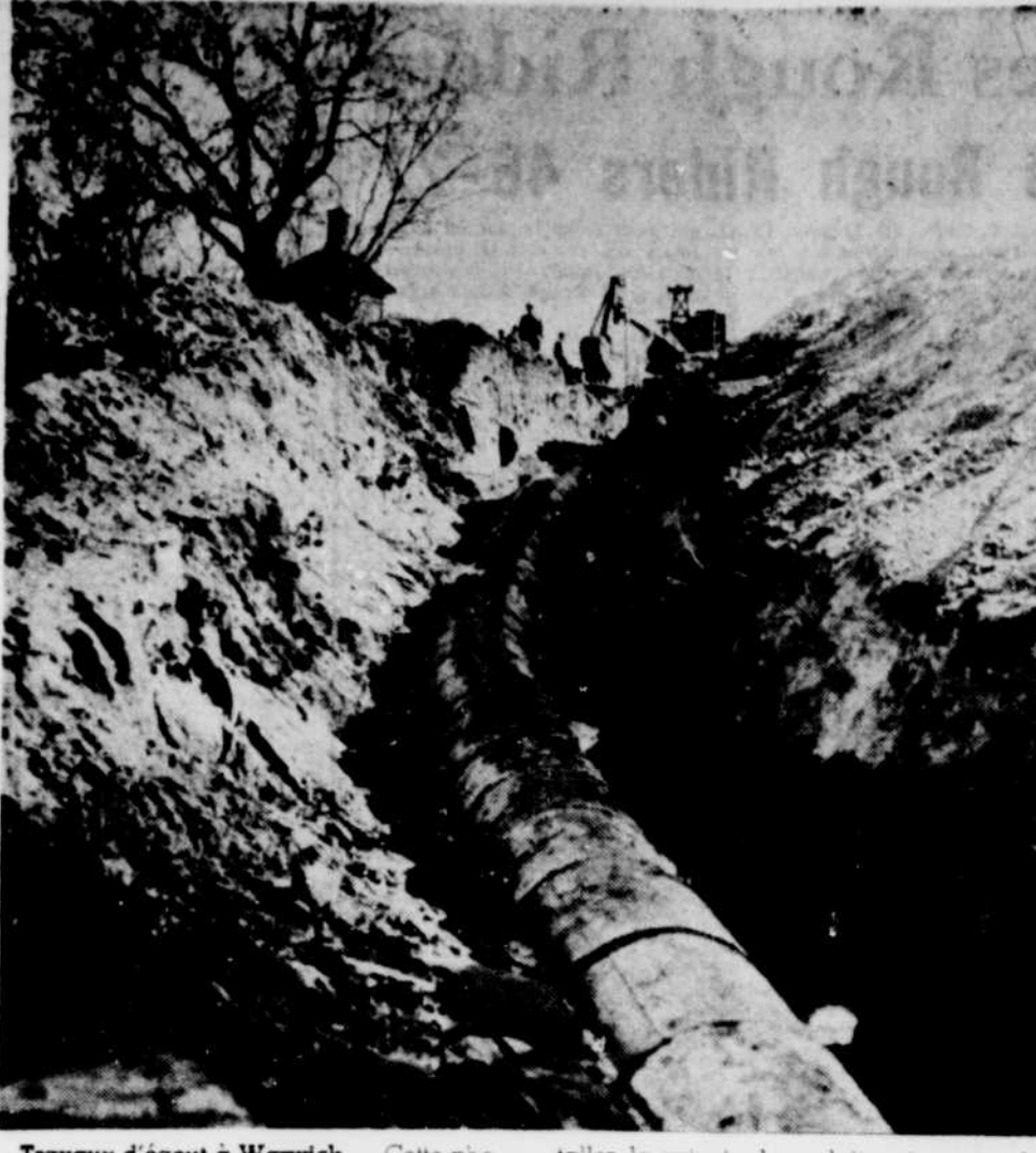
Travaux d'égout à Warwick — Cette photo montre clairement l'ampleur des travaux qui se poursuivent actuellement à Warwick à la sortie de la ville du côté du cimetière. On est présentement à installer le principal conduit qui servira la partie neuve de Warwick ainsi que plusieurs rues existant avant l'ouverture du Boulevard No 1 et de la rue Gingras.
