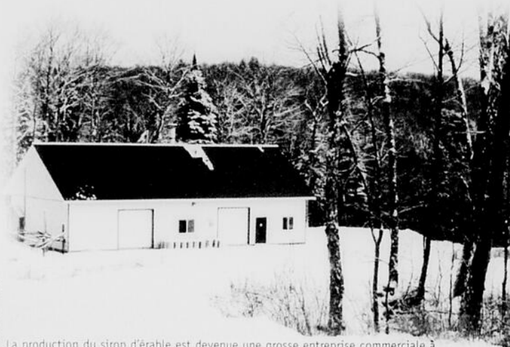
La production du sirop d'érable est devenue une grosse entreprise commerciale à Kitigan Zibi. Niché dans les bois au sud de Maniwaki, ce bâtiment renferme un évaporateur et trois cuves en fibre de verre d'une capacité de 2 300 litres.
