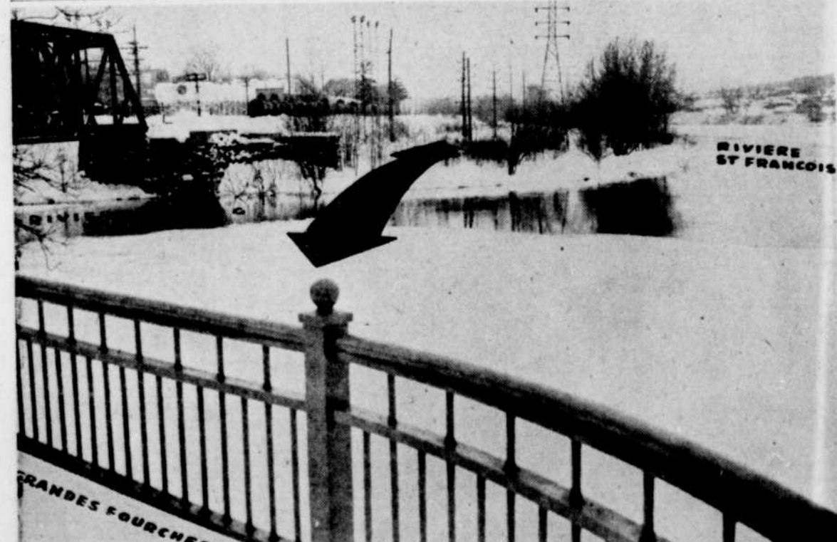
Un pont sur la Magog. — Cette photographie illustre l'extrémité nord de la rue des Grandes-Fourches, endroit où pourrait être construit un pont enjambant la rivière Magog, parallèlement au pont de la voie ferrée,
