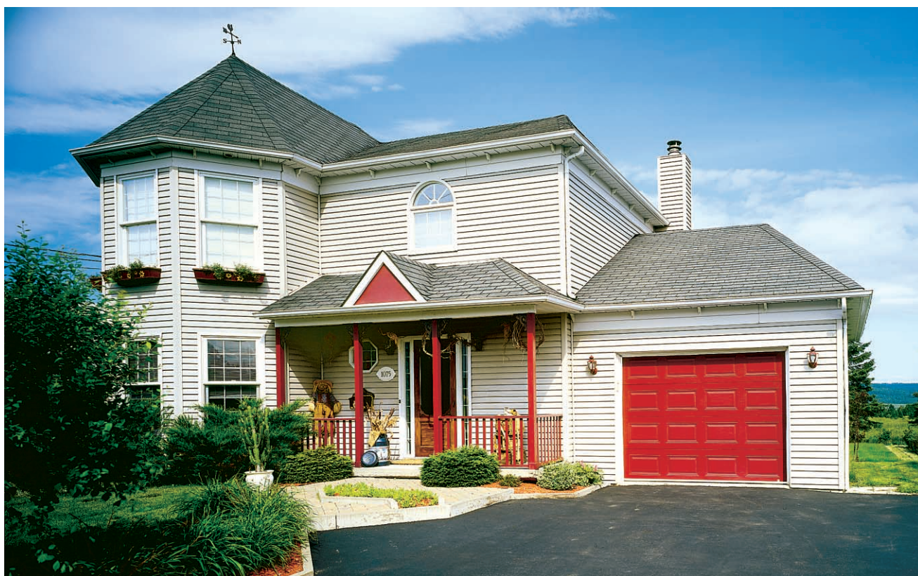
Un garage monopolise de 20 à 30 pieds de la façade. On doit donc veiller à ce qu'il s'agence parfaitement à l'architecture de la maison, notamment aux portes et fenêtres.
