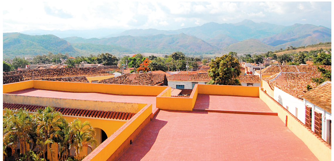
C'est du toit de l'ancien couvent de San Francisco de Asís, reconnaissable à son clocher jaune, que l'on peut observer le panorama grandiose de la Vallée de los Ingenios.
