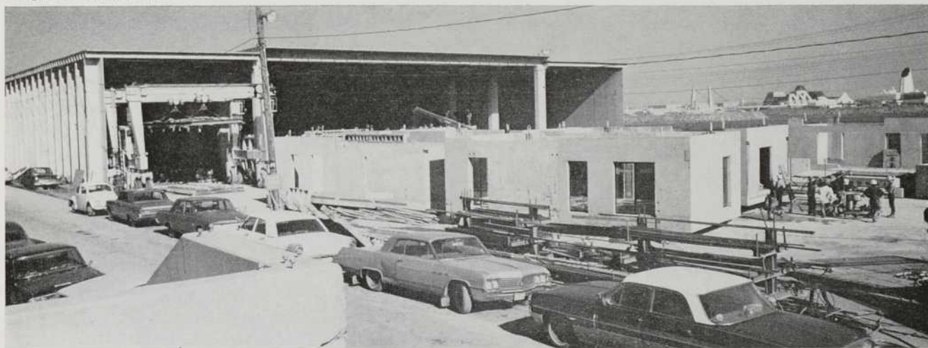
hangar de fabrication
