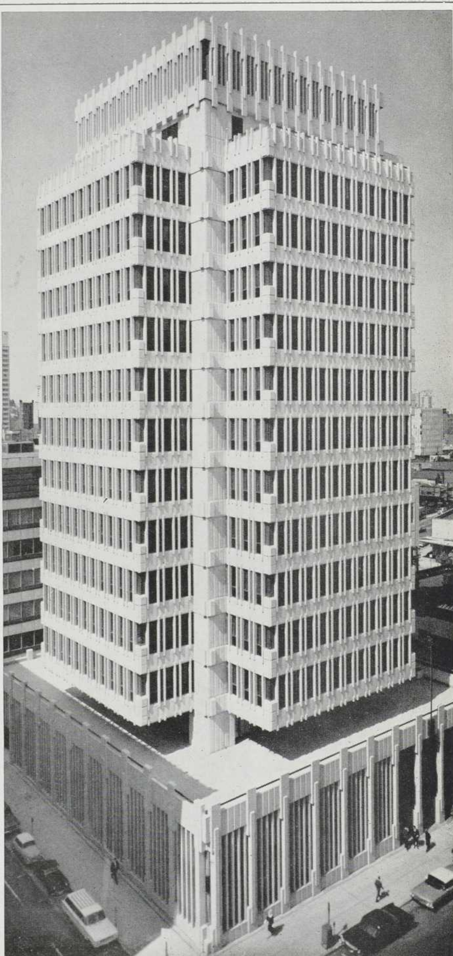
Architectes: Thompson, Berwick, Pratt & Associés, Vancouver. Architecte du projet: W. W. Rennie. Architectes conseils: Chadwick & Pope, Montréal. Ingénieurs conseils: O. Safir & Co. Ltd., Vancouver. Entrepreneur général: The Foundation Co. of Canada Ltd. Unités extérieures préfabriquées: Continental Marble & Granite Ltd., et Bordignon Masonry Ltd.
