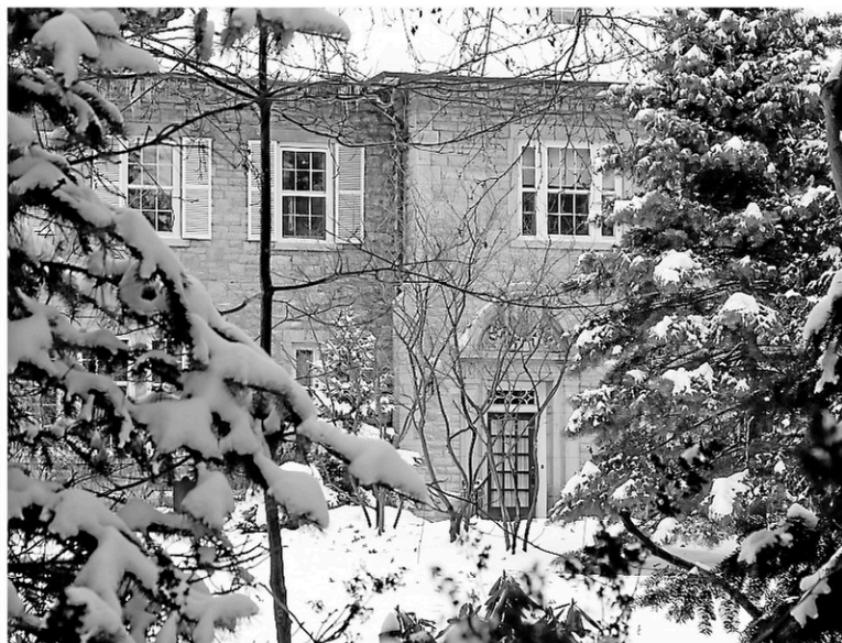
La résidence officielle du premier ministre n'a pas fait l'objet de travaux de rénovation depuis l'époque où Louis St-Laurent était premier ministre, soit depuis six décennies. — PHOTO PATRICK WOODBURY, LE DROIT
