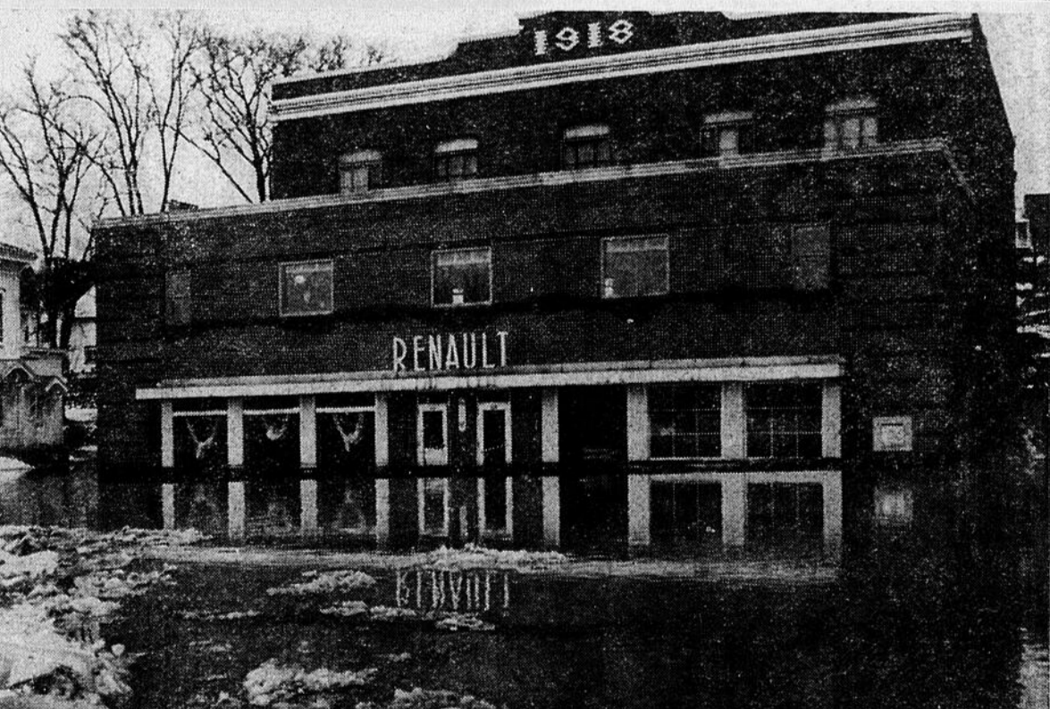
UN DES SINISTRES — Le Magasin Renault a vu cette année la quarantième débâcle de la Chaudière. A cet endroit du quartier commercial, l'eau et la glace ont atteint une hauteur de plus de dix pieds. La ligne noire indique le
