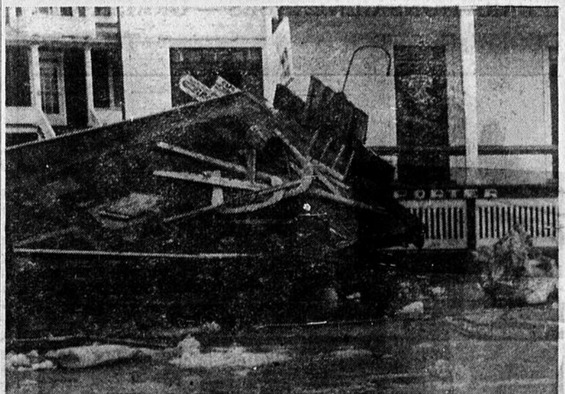
AUTRE MEFAIT — Le garage de M. J.-A. (Baby) Loubier a été transporté par la force de la glace et de l'eau sur une distance de cinq cents pieds, pour s'échouer en face au Marché Suprême. (Photo Studio L'Eclairer)
