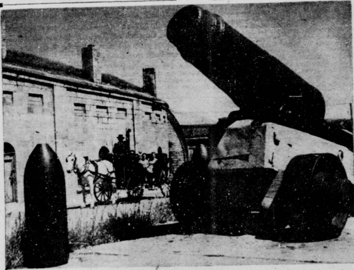
Rénovation de la Citadelle de Québec
