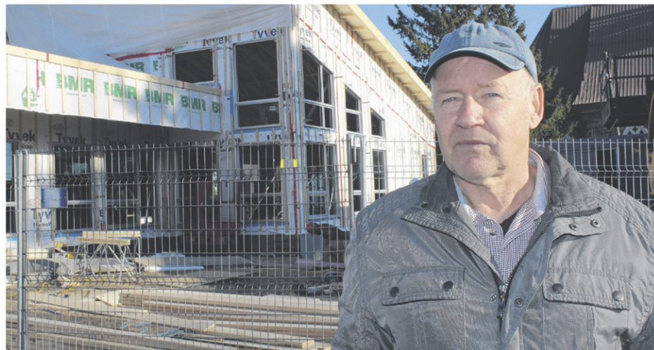
Les citoyens de Saint-Sévère auront accès à ces nouveaux locaux dès le début du mois de janvier 2017 assure le maire Laurent Lavergne. (Photo TC Media - Pier-Olivier Gagnon)
