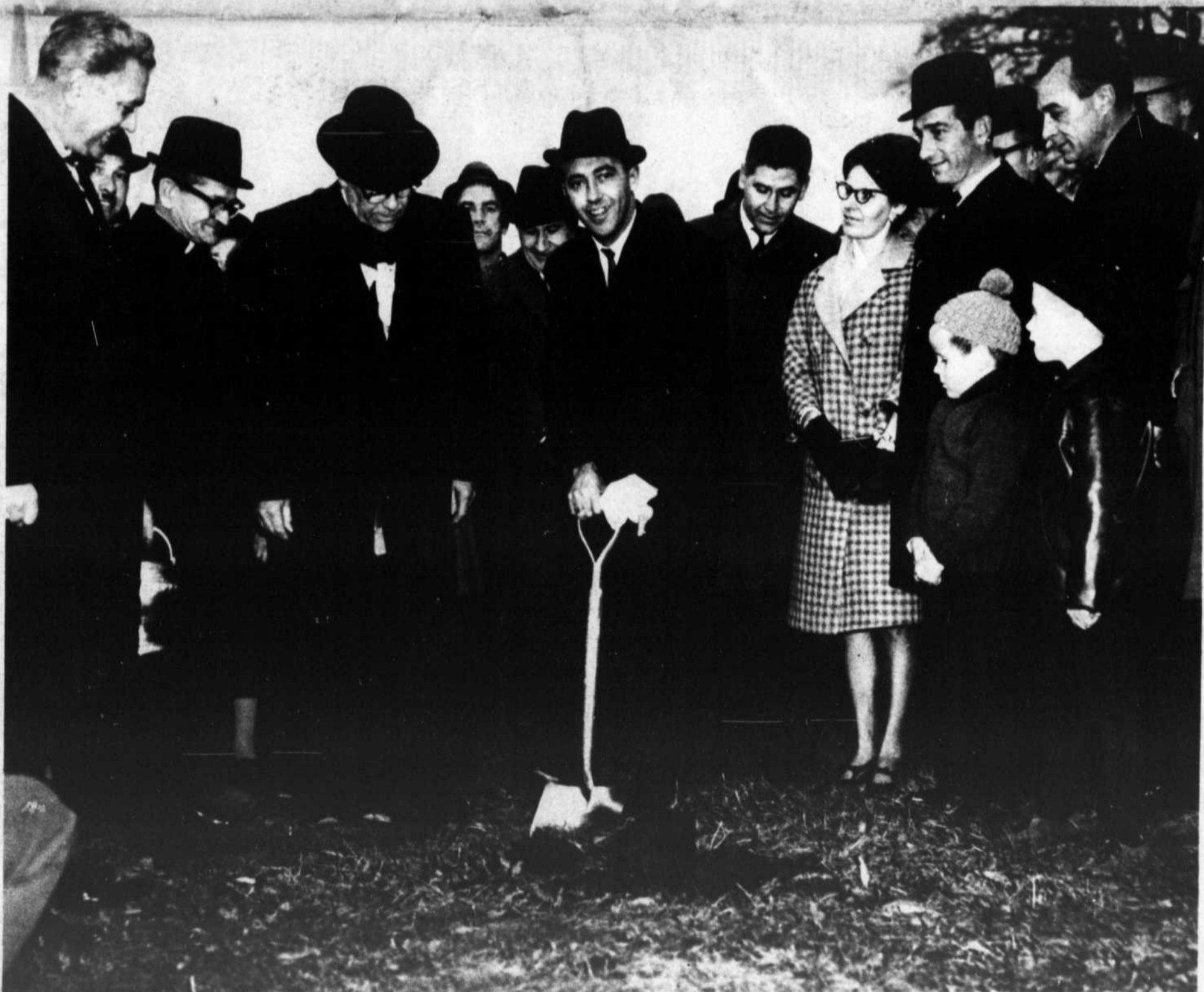
L'honorable Clément Vincent, ministre de l'Agriculture, enlève la première pelletée de terre pour la construction du futur centre culturel à St-Grégoire, secteur de la ville de Bécancour.
