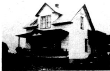
3 rue Bernier 24 x 22. Chauffage eau chaude
