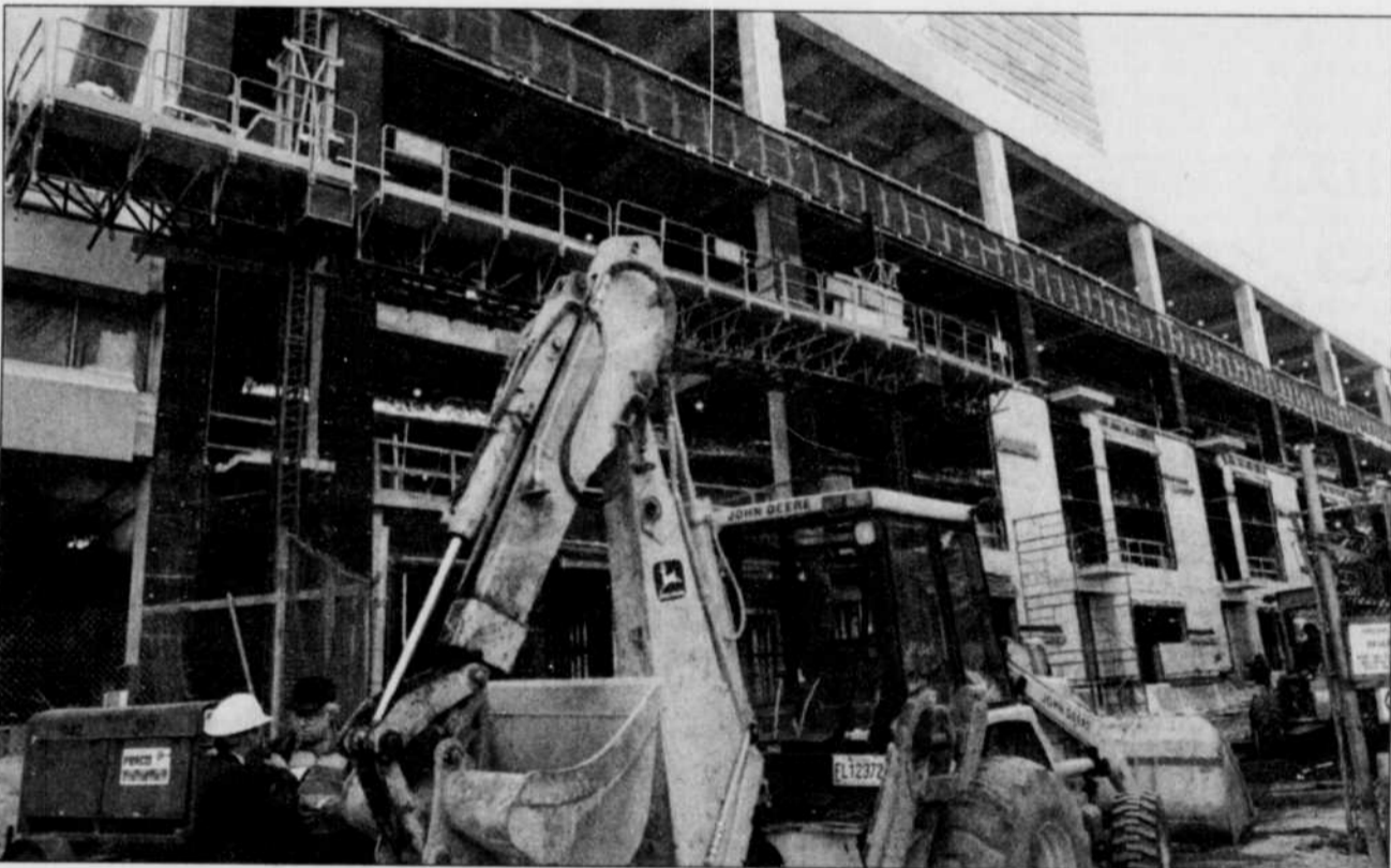
Même si les travaux de construction avancent à grands pas, le nouveau centre des congrès de Québec ne pourra ouvrir ses portes avant un an encore.
