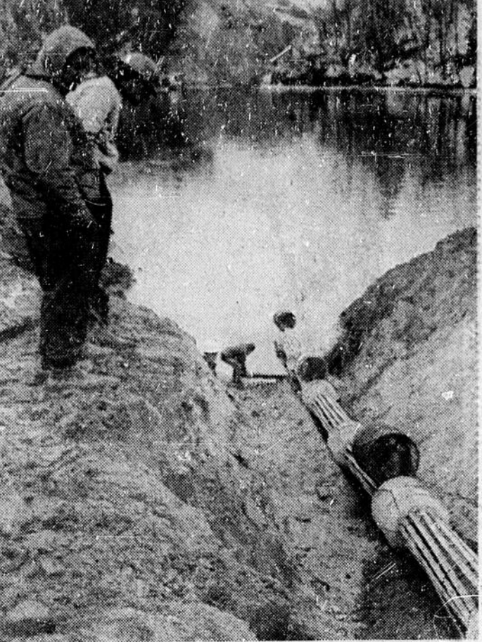
CONDUIT DE GAZ NATUREL SOUS-MARIN — Après des travaux de plus d'une semaine et demie, un conduit principal d'acier de 750 pieds de longueur et de 12 pouces de diamètre a pu être immergé au fond de la rivière Rideau, vendredi après-midi. Ce conduit, qui traverse la rivière Rideau à l'angle du chemin MacFarlane sur la route de Prescott, est le quatrième conduit sous-marin de gaz naturel à être construit par l'Ottawa Gas depuis quelques années.
