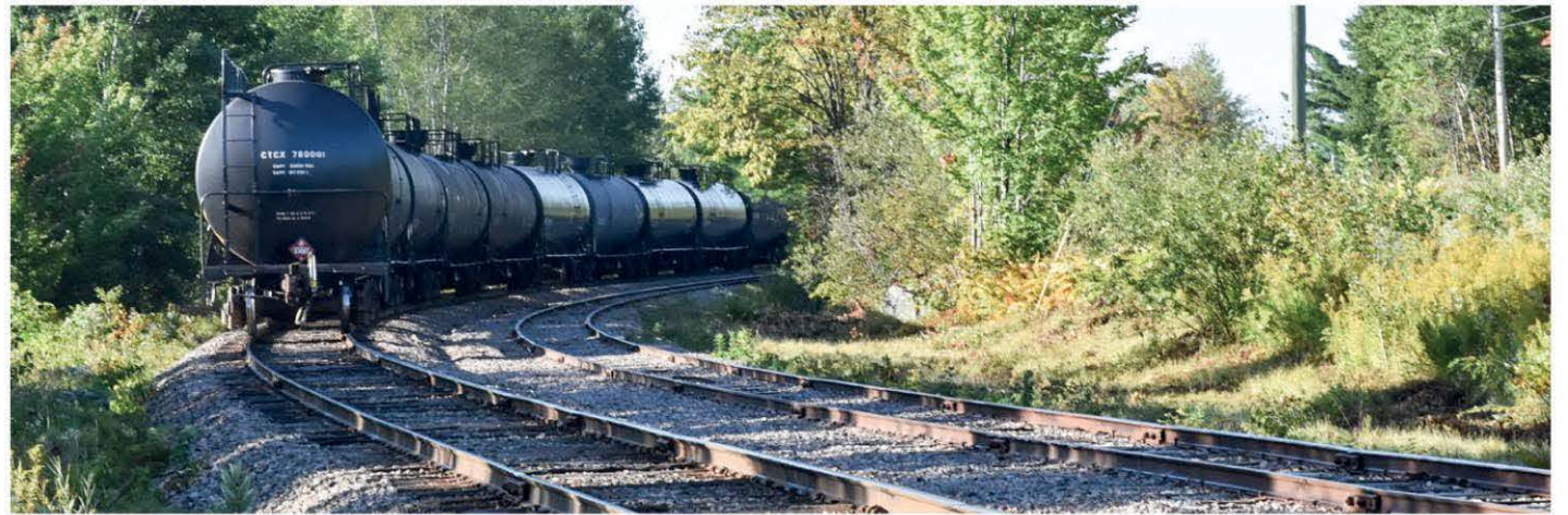
La voie ferrée traverse le cœur des périmètres urbanisés des villes de Boucherville, Varennes et Verchères, dont notamment un vaste quartier résidentiel de plus de 5,5 kilomètres à Boucherville.
