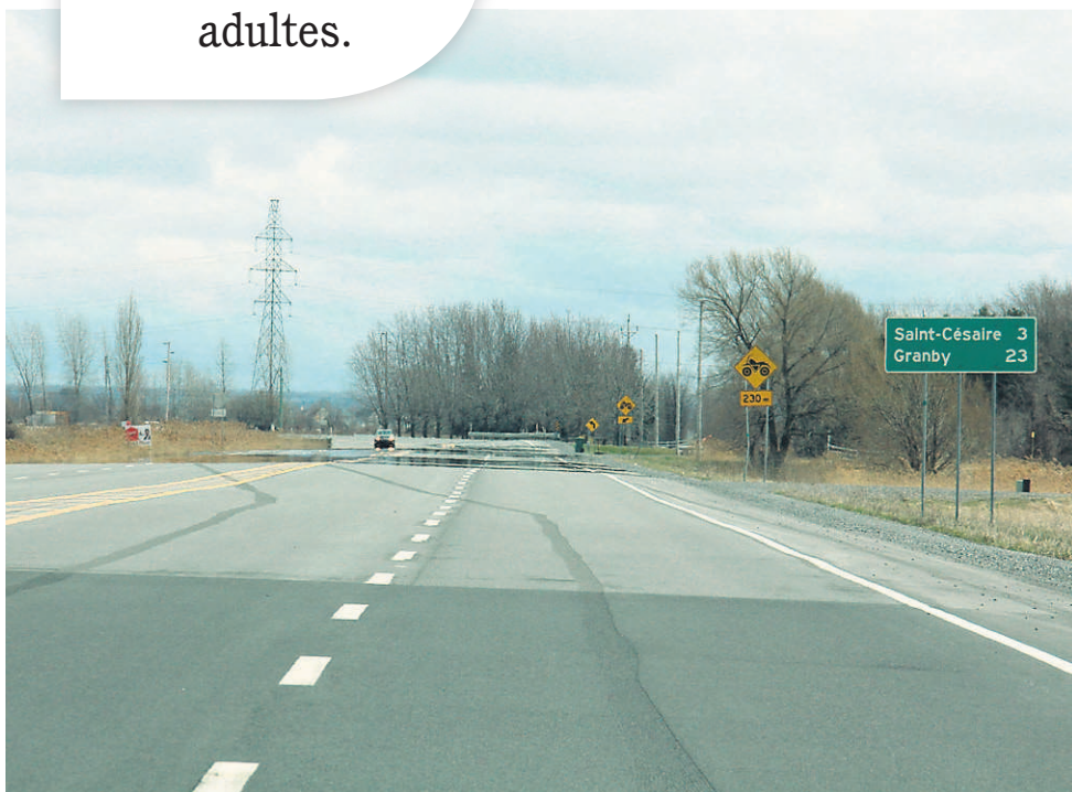
Beaucoup de travaux de pavage de routes et de rues ont été réalisés en 2012.
