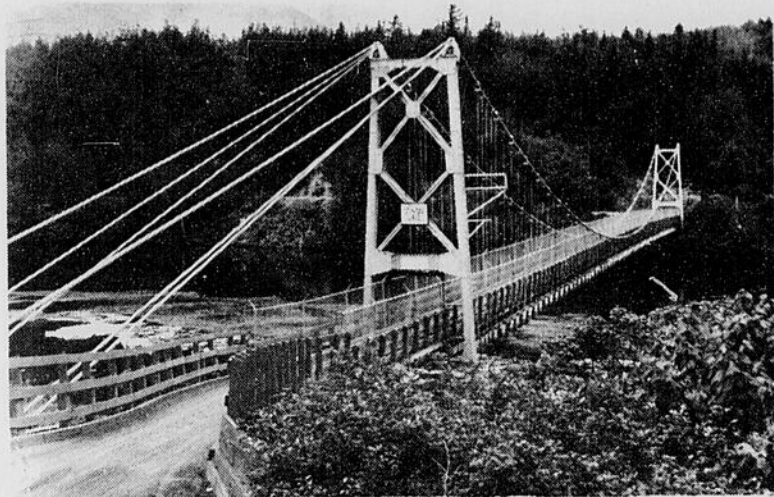
Voilà le pont qui recevra dans les semaines à venir, de fortes modifications. L'approche Est sera également modifiée.
