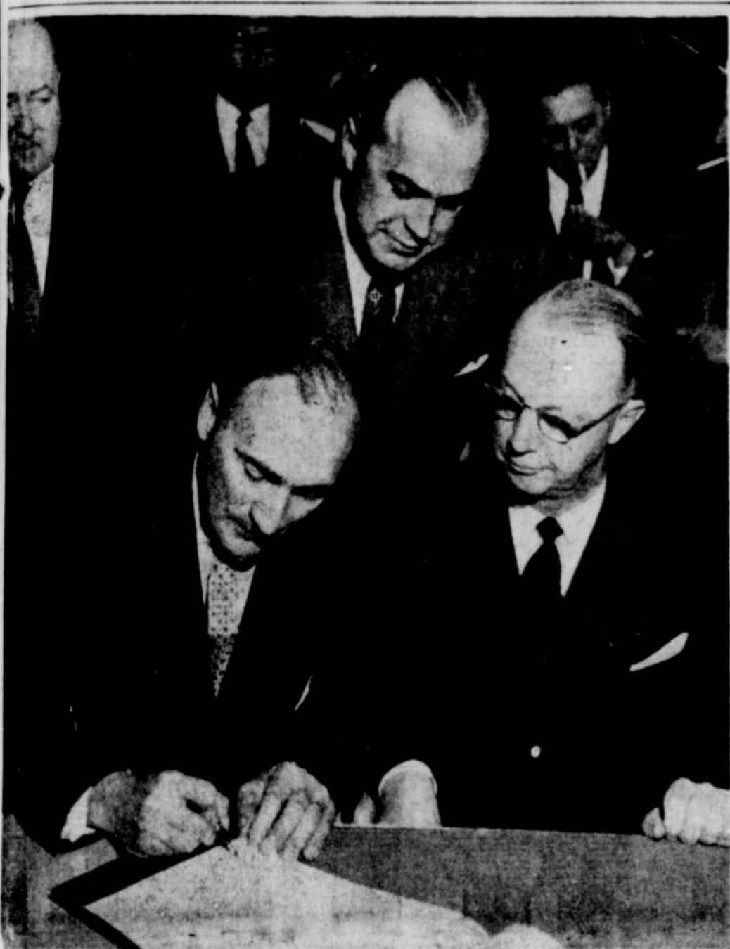
A LA SIGNATURE DE LA CONVENTION entre Ottawa et Québec, permettant de compléter la route transcanadienne, après dix ans de travaux, on remarque au premier plan, de g. à d. l'hon. Bernard Pinard, ministre de la Voirie dans le cabinet Lesage, l'hon. David-J. Walker, ministre des Travaux Publics dans le cabinet Diefenbaker. Au second plan, derrière eux, le ministre des Transports, l'hon. Léon Balcer, député de Trois-Rivières.
