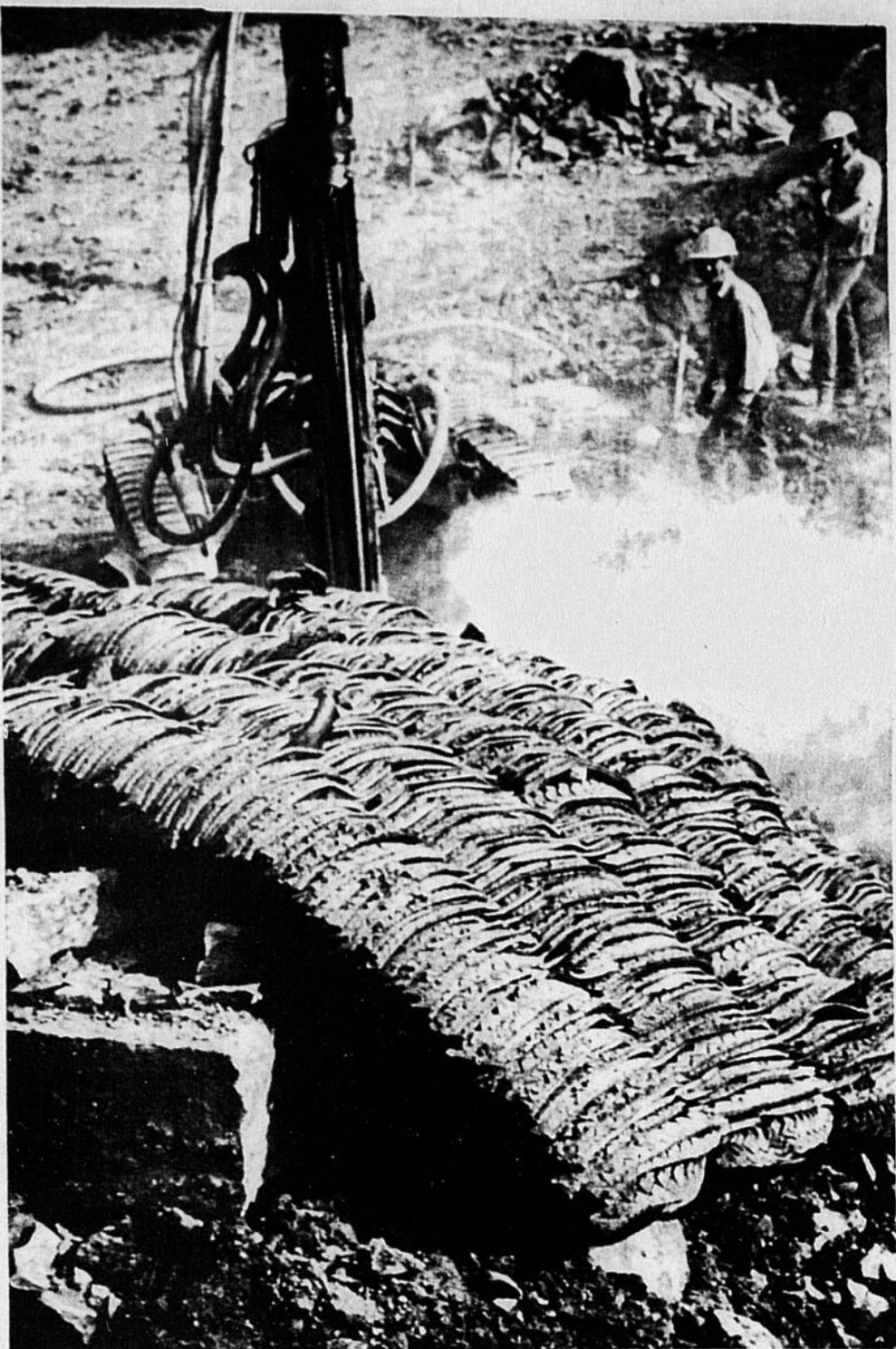
Un tapis formé de sections de pneus sert à amortir le dynamitage à l'emplacement de l'expansion de l'usine GoodYear de Valleyfield. Etendu au-dessus des charges, le tapis retient au minimum le bruit et l'éparpillement des débris. Ici, l'équipe fore des trous où l'on introduit des explosifs en vue d'enlever le roc qui entrave l'excavation.
