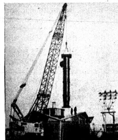
Mise en place d'une des trois pompes.
