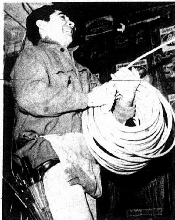
Les conduits de courant prennent place
