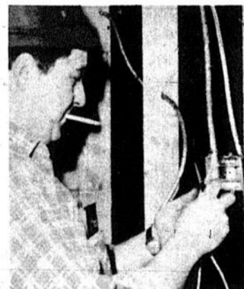
Les réceptacles d'électricité à leur place
