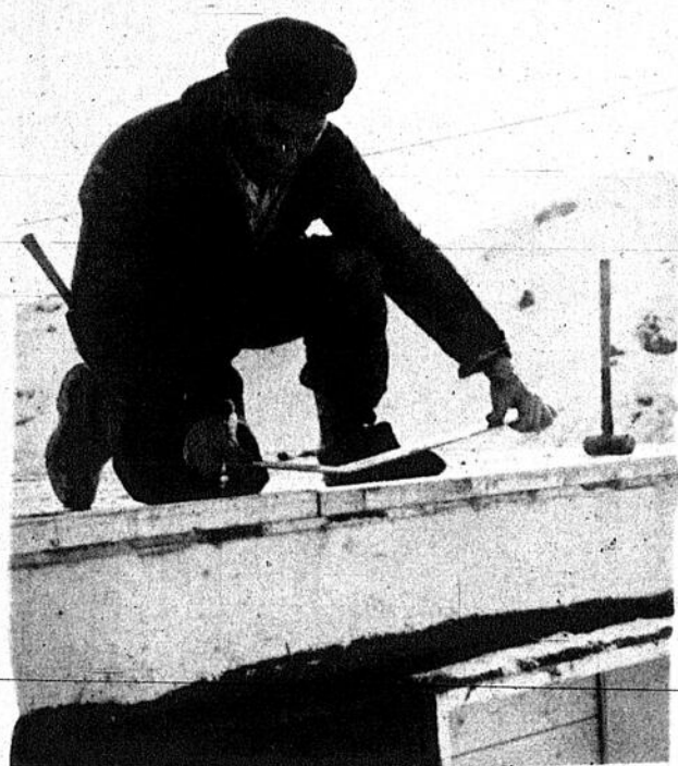
Bien d'aplomb, la construction commence
