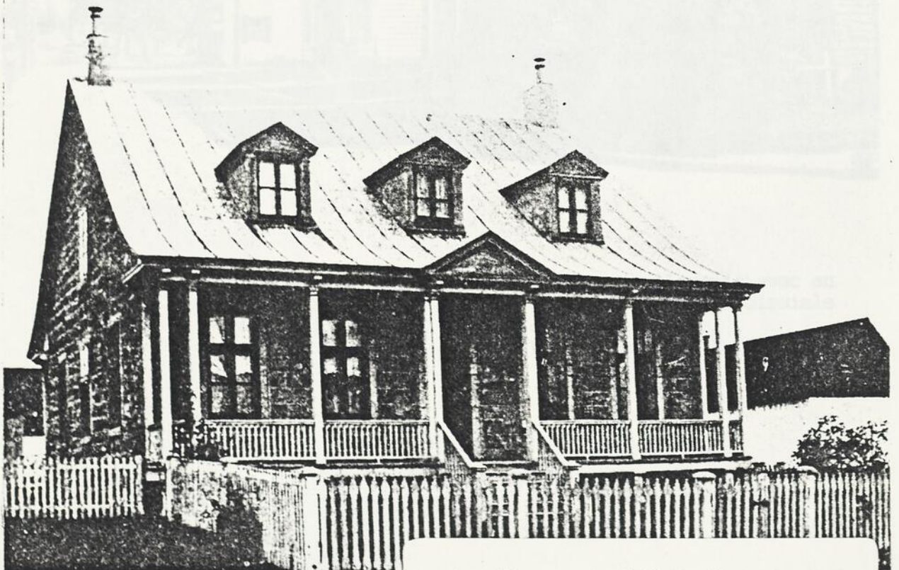
Fig. 92 Vue du 9950 boulevard Gouin est en direction «est».
