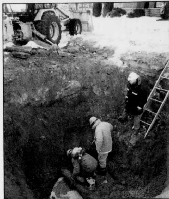
À Nicolet, la température serait à l'origine du bris d'une conduite d'eau de 200 millimètres, ce qui a privé d'eau potable une quinzaine de foyers pendant quelques heures.
