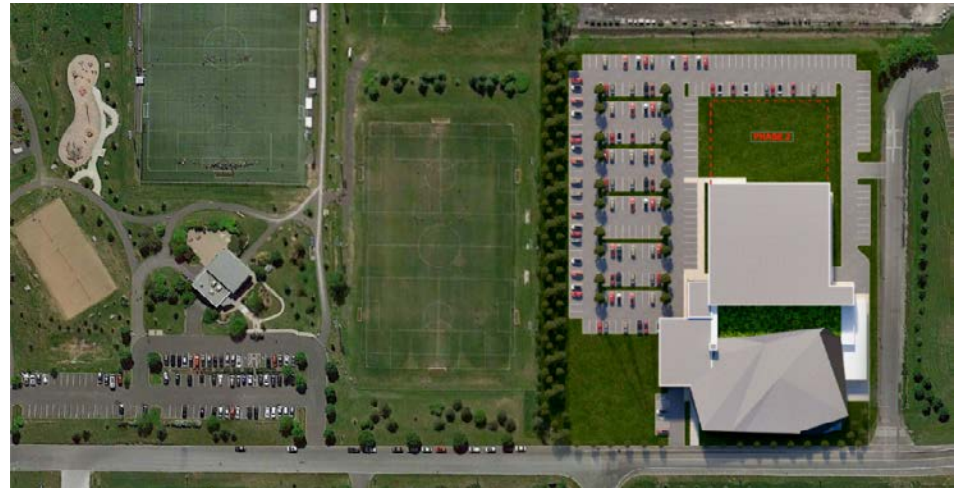
Le site du futur complexe sportif du parc Marie-Victorin. (Photo : courtoisie)
