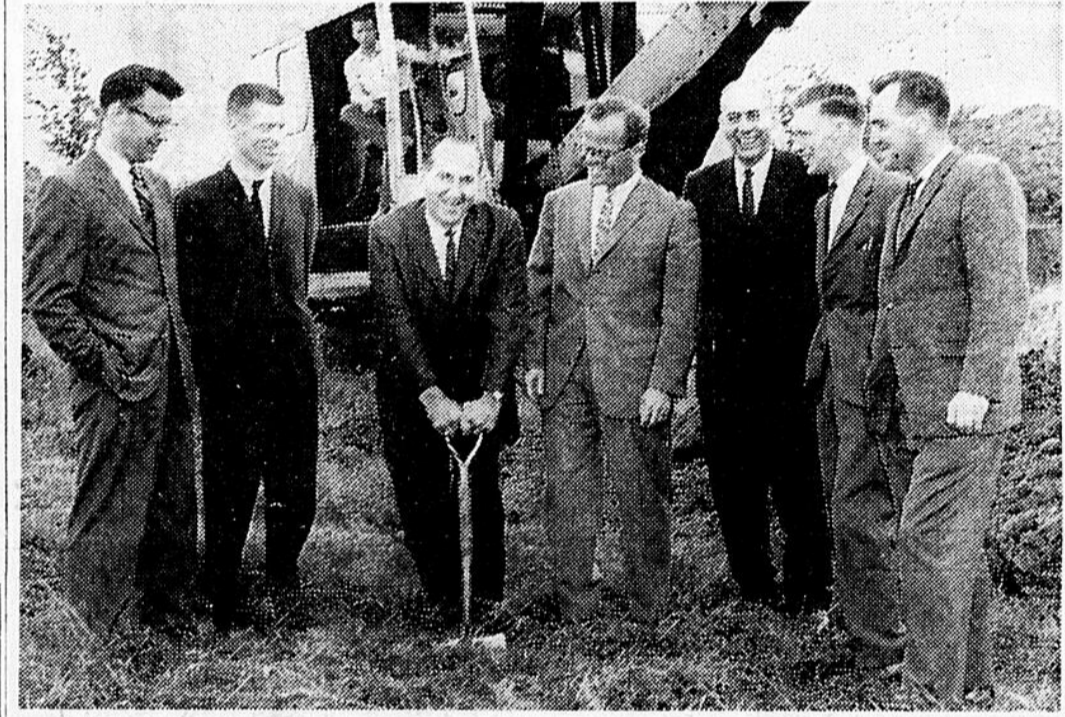
Nous voyons ici Me Pierre Laporte, député de Chambly, procédant à la levée de la première pelle-étée de terre sur le site de l'usine que la compagnie Cal-Sil Products Ltd. entreprend de construire dans les limites de la Cité de Jacques-Cartier. Entourant le député à cette occasion, nous remarquons MM. F.R. Graham, président du Conseil d'administration de Cal-Sil; R.K. Robertson, gérant des ventes de Dominion Lime; Marcel Désourdy, vice-président de Désourdy Construction. (Photo Artiste, R.L. Gendron, Longueuil)
