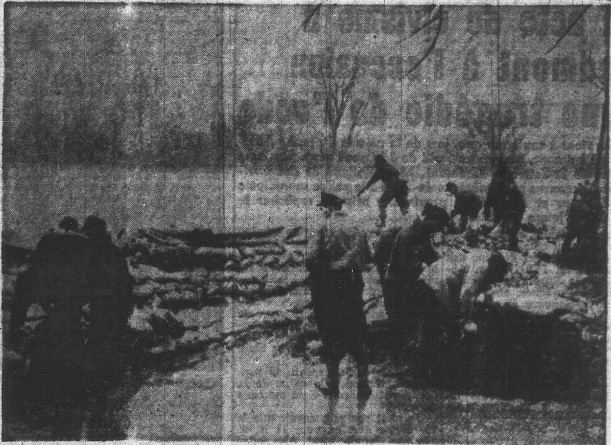
LE SABLE SAUVEUR — Des forçats et des membres de la garde nationale de l'Indiana travaillent côte à côte à la construction d'une digue de sacs de sable de quatre pieds de haut et de six pieds d'épaisseur pour faire échec à la Wabash. (Fac-similé UPI — "Montréal-Matin")
