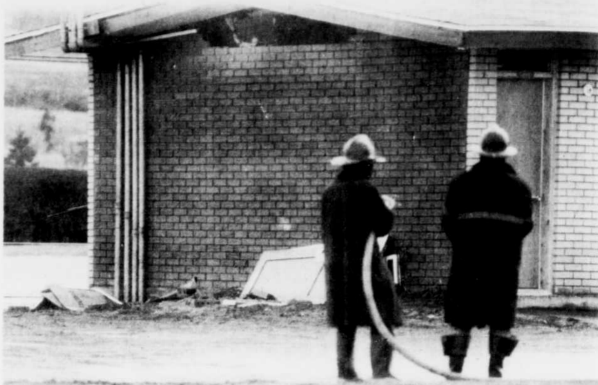
Les pompiers de Cookshire ont été appelés hier matin au garage Calex, situé rue Principale Est à Cookshire, à la suite d'une explosion qui a infligé des brûlures au troisième degré à un employé. Les dégâts de la conflagration sont peu visibles de l'extérieur, puisque celle-ci s'est produite au sous-sol de l'édifice. Seul le haut du mur arrière a été soufflé.
