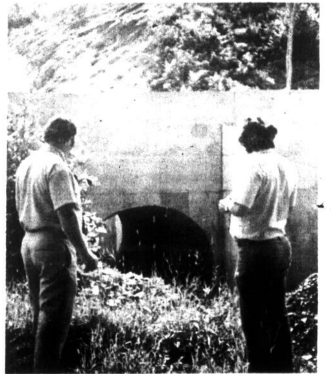
Deux tunnels, comme celui-ci, permettront aux spectateurs de passer en-dessous de la piste. (Photo L'Union)
