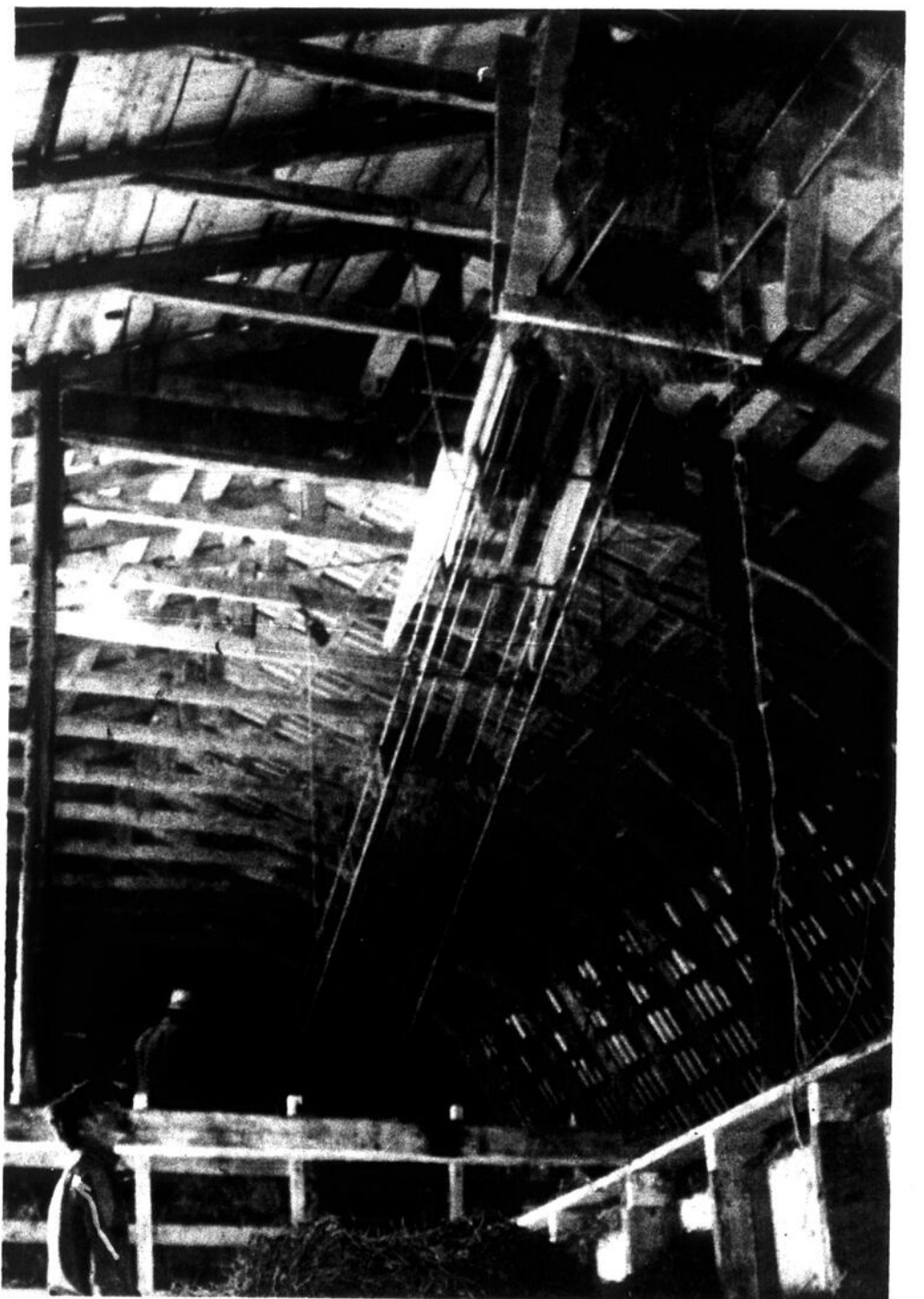
La mécanisation de la ferme est démontrée ici par le système de convoyeur pour le foin.
