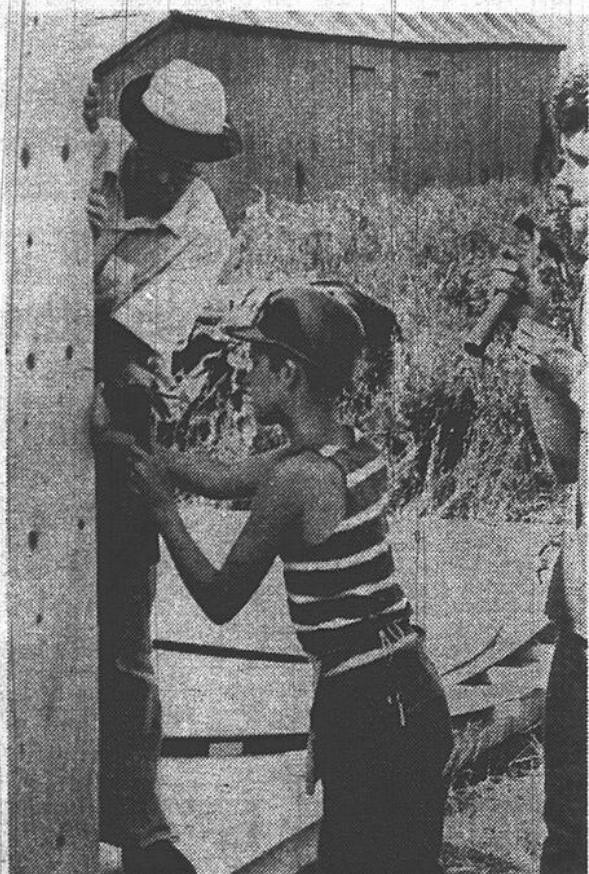
Les jeunes ne sont pas laissés de côté à Terrebonne où plusieurs travailleurs volontaires s'affairent à la préfabrication de trois estrades et d'une cafétéria qui couvriront un peu plus de 15,000 pieds carrés au stade du parc Jarry.
