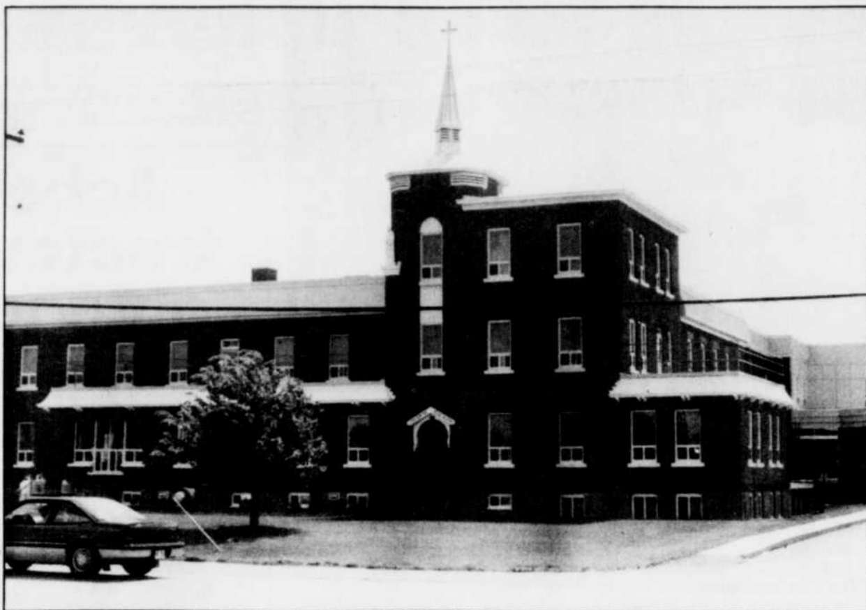
Le Foyer Saint-Célestin, qui a été restauré de façon importante ces derniers mois, demeure le premier employeur de Saint-Célestin avec 70 travailleurs. D'une capacité de 52 bénéficiaires, le foyer a une vocation de centre d'hébergement et de soins de longue durée. La direction est assurée par Sr Rita Leclerc.
