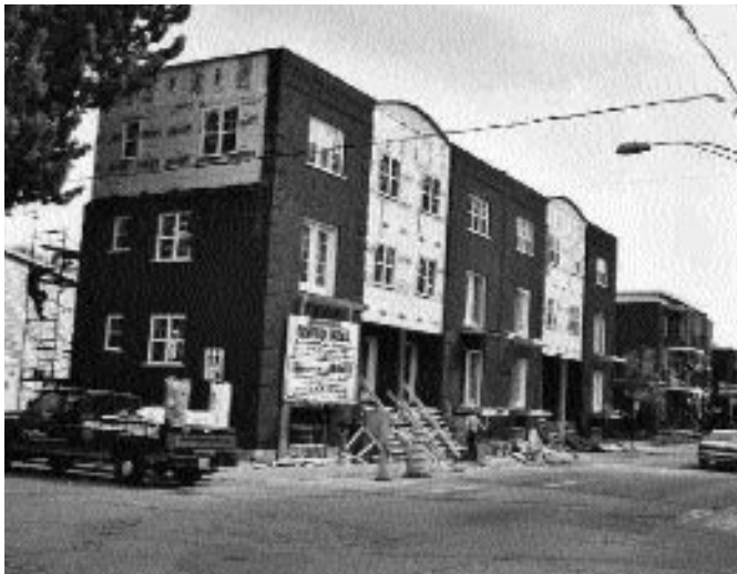
Construction de deux immeubles jumelés totalisant 16 logements dans un quartier central de Trois-Rivières
