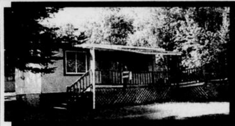
Chalet situé sur un grand terrain boisé. Il n'y a aucune inondation sur le terrain.
