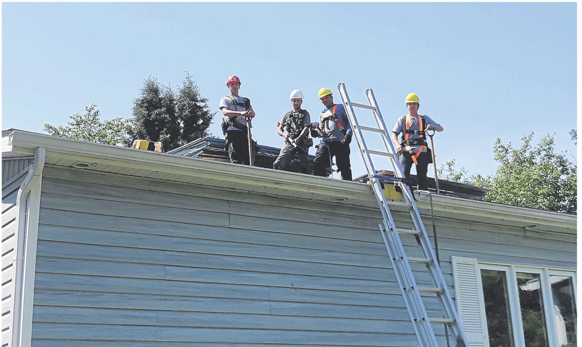
Sur une toiture le bardeau d'asphalte, le mercure peut atteindre une température de 77 à 80 °C sous le soleil d'été.—PHOTO LE QUOTIDIEN, ROGER BLACKBURN
