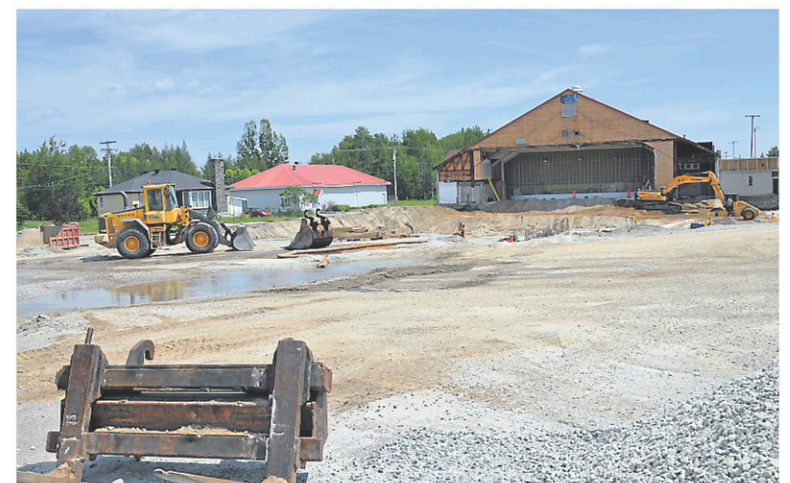
La construction du complexe Aquagym a commencé il y a quelques mois et l'ouverture est prévue en janvier 2021. — PHOTO LE QUOTIDIEN, GUILLAUME ROY
