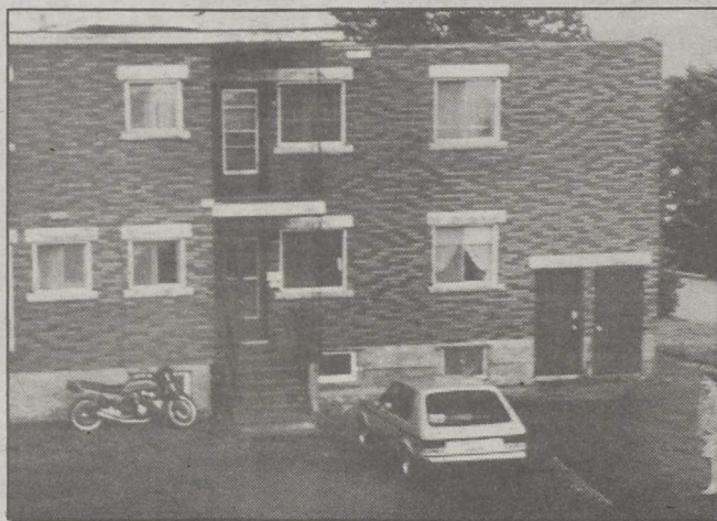
Une partie du toit de cet édifice a été soulevée pour être ensuite rabattue sur la partie restante.
