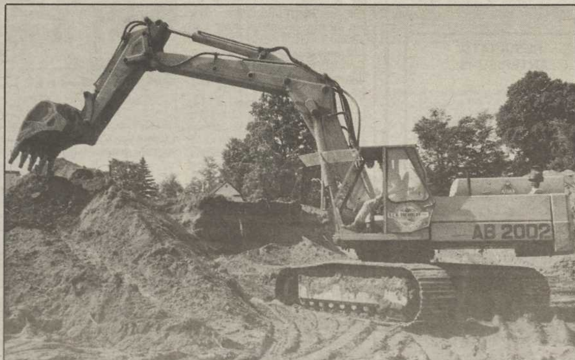
La construction de la "Place du quartier", au coin des rues Albert et Williams, a débuté la semaine dernière. Les travaux devraient être terminés à la mi-octobre.
