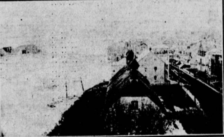
L'INONDATION A ST-JOSEPH DE BEAUCE — (Photo. Gédéon Cloutier, St-Joseph.)
