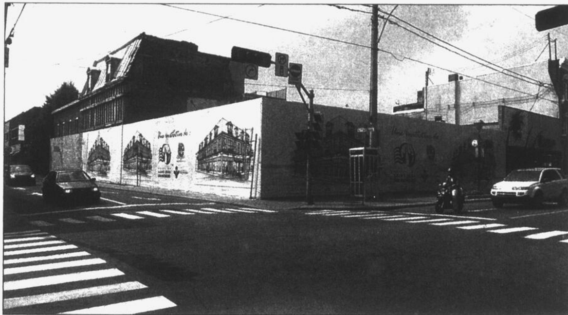
La présence d'amiante dans l'un des bâtiments composant les ruines du site du 202 Richelieu complique sa démolition.
