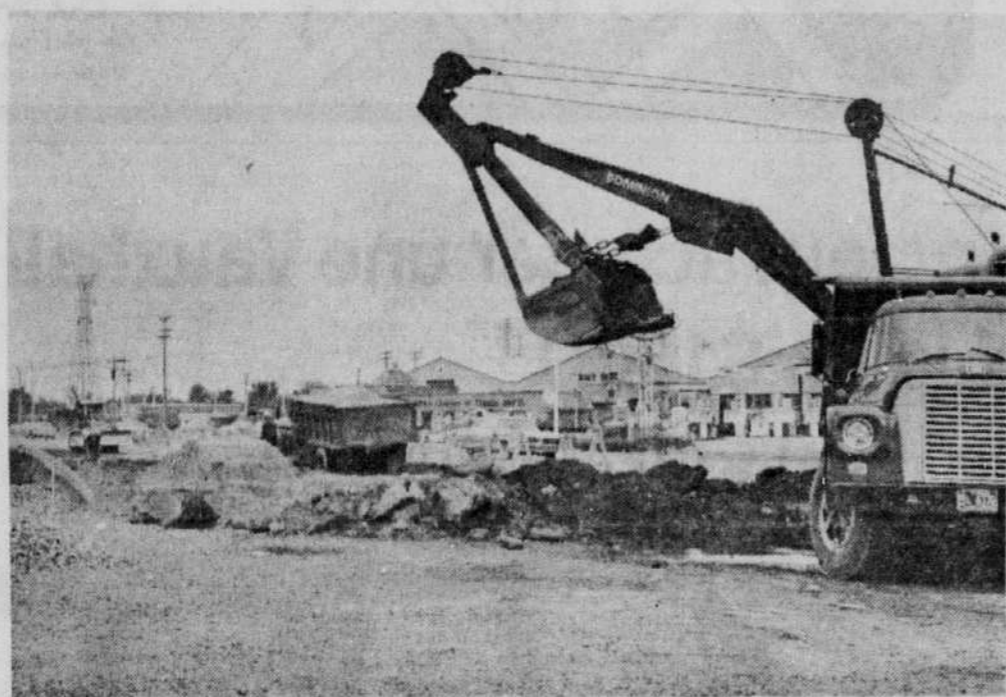
Travaux d'élargissement du boulevard Charest, entre Marie-de-l'Incarnation et le boulevard Saint-Sacrement.
