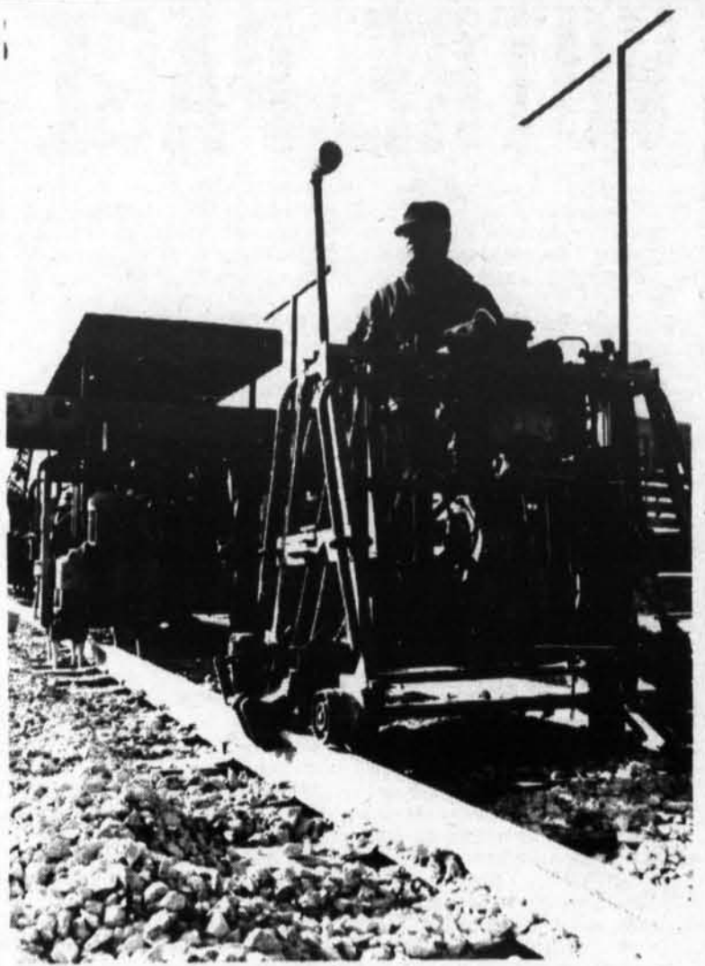
Méthodes modernes d'entretien - Le vérin mécanique à l'avant-plan lève les rails à une hauteur déterminée d'avance tandis que le bourroir à sa suite force le ballast sous les rails, assurant ainsi une pente conforme aux normes. Le matériel mécanisé épargne temps et travail dans l'entretien de la voie de CP Rail.
