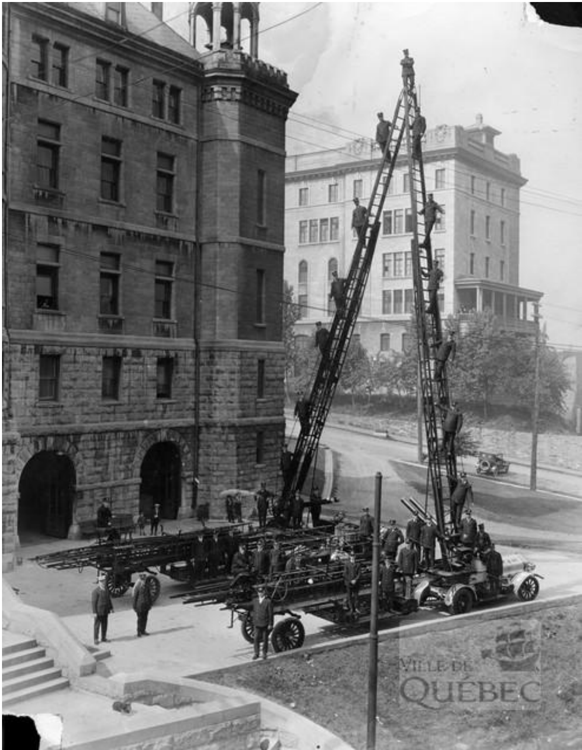
Figure 13 : Caserne de pompiers située dans l'hôtel de ville de Québec. Photographie datée de 1924. Archives de la Ville de Québec.
