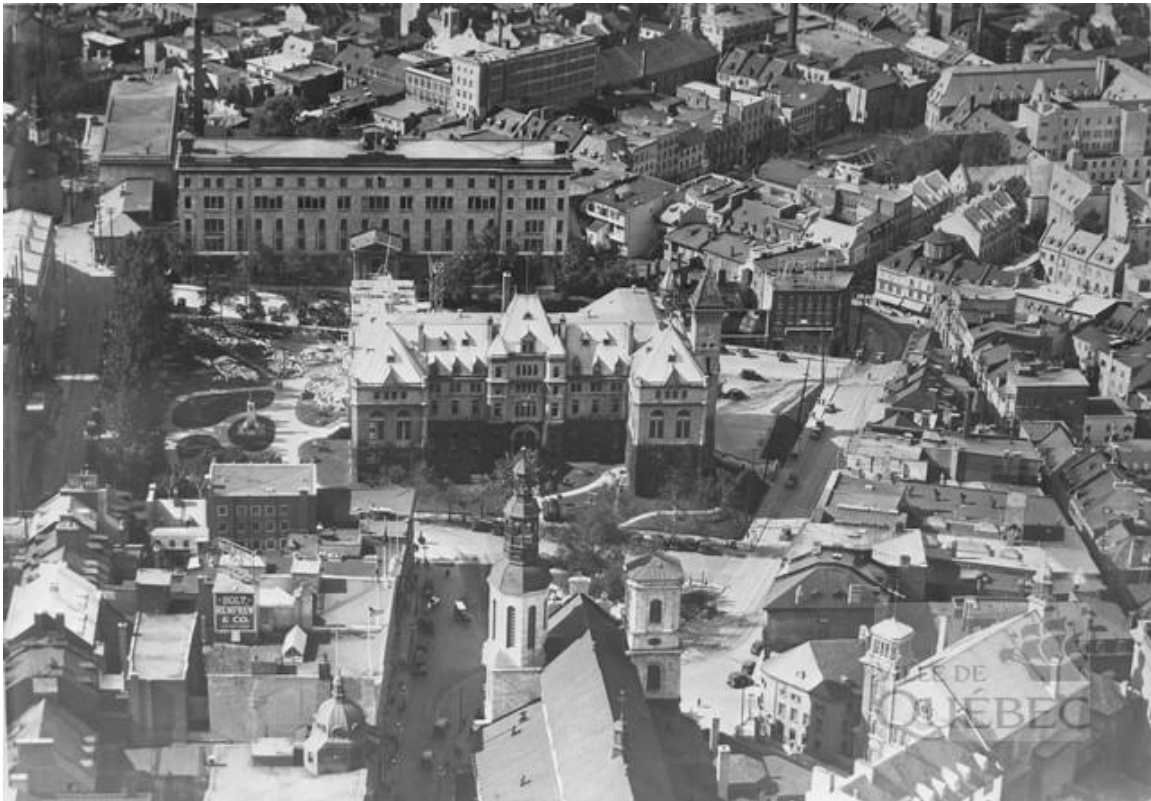
Figure 47 : Photographie aérienne montrant au nord une cour d'aspect bétonnée, 1930. Archives de la Ville de Québec.
