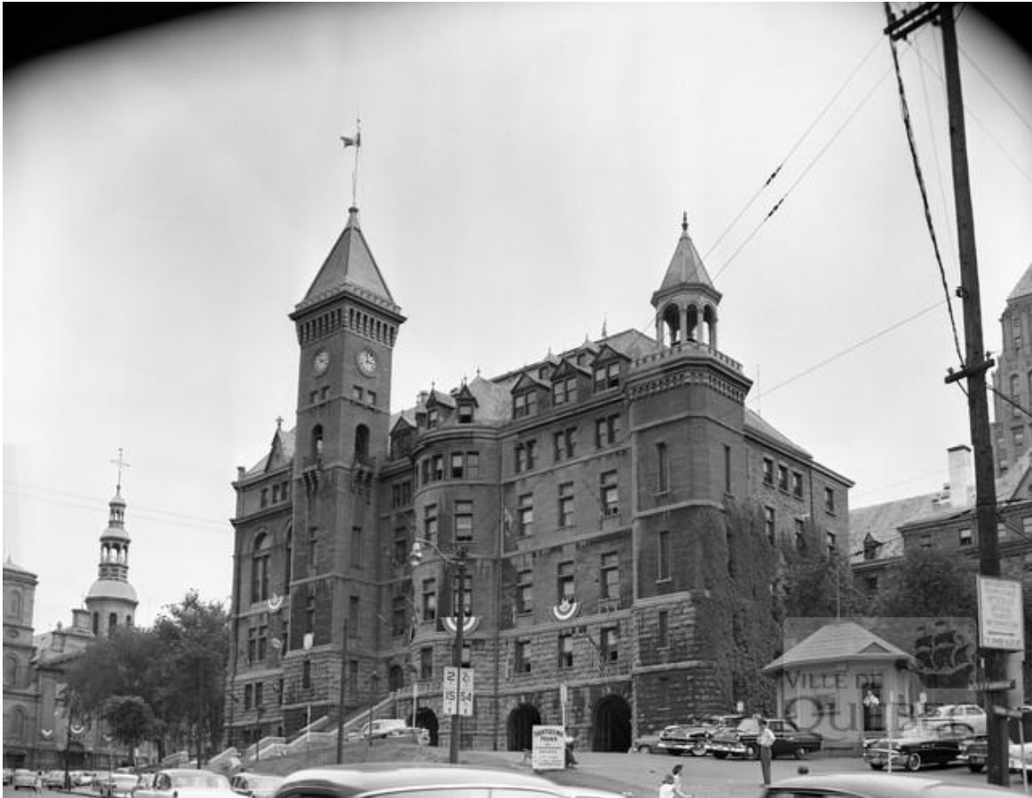
Figure 14 : Poste de taxi (petit bâtiment octogonal) et stationnement à ciel ouvert sur l'ensemble du secteur nord et ouest de l'hôtel de ville. Photographie prise en 1958. Archives de la Ville de Québec.
