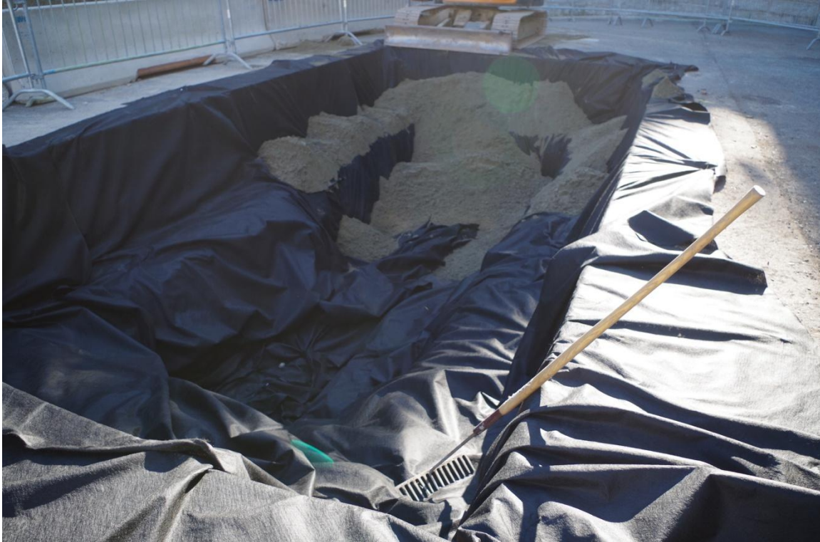
Figure 2 : Supervision du remblaiement de la sous-opération CeEt-35-14A (Photo : Anne-Marie Faucher).
