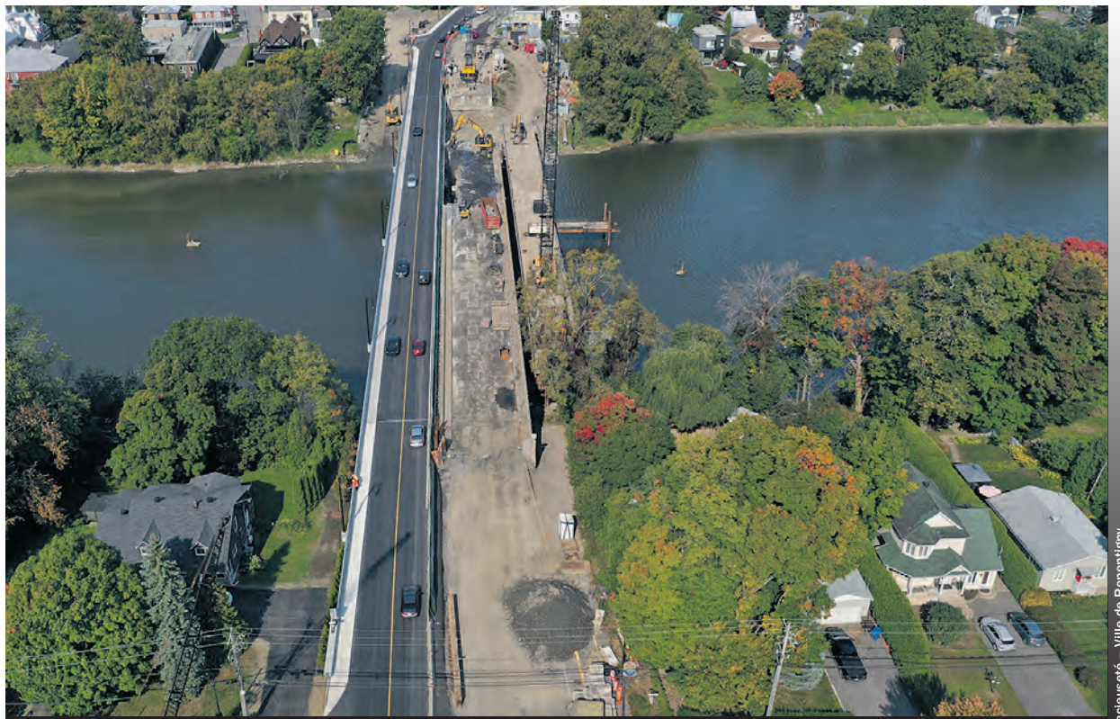
Après la démolition de la section de l'ancien pont Rivest, la Ville de Repentigny est maintenant prête à procéder à sa reconstruction.
