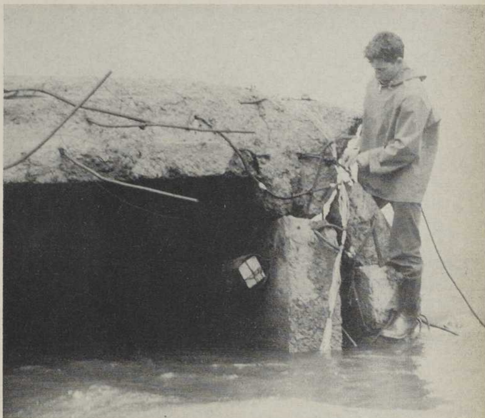
PRÉPARATIFS DE L'EXPLOSION D'UN CAISSON EN BÉTON ARMÉ, PRÈS DE QUÉBEC.
