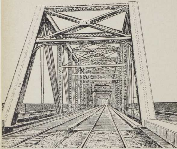
L'ENTRÉE DU PONT VICTORIA, AU DÉBUT DU SIÈCLE, PEU APRÈS SA RECONSTRUCTION. À L'ORIGINE, EN 1860, IL S'AGISSAIT D'UNE STRUCTURE TUBULAIRE À UNE SEULE VOIE.
