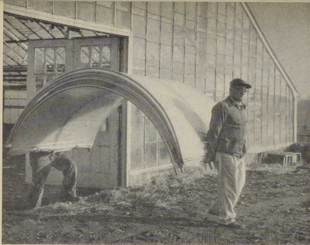
LES ÉLÉMENTS DE LA SERRE DÉMONTABLE SONT CONSTITUÉS DE TUBES DE POLYÉTHYLÈNE TENDUS SUR UNE ARMATURE MÉTALLIQUE. CETTE SERRE PROTÈGE LES PLANTS CONTRE LES INTEMPÉRIES, TOUT EN RETENANT LA CHALEUR ET L'HUMIDITÉ.
