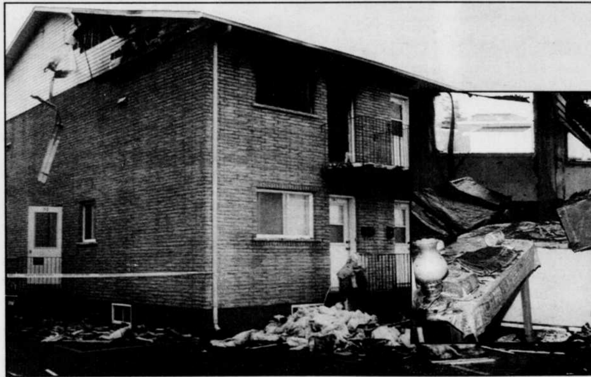
Les pompiers ont rapidement maîtrisé l'élément destructeur niché dans le logis du coin arrière de l'édifice de deux étages.
