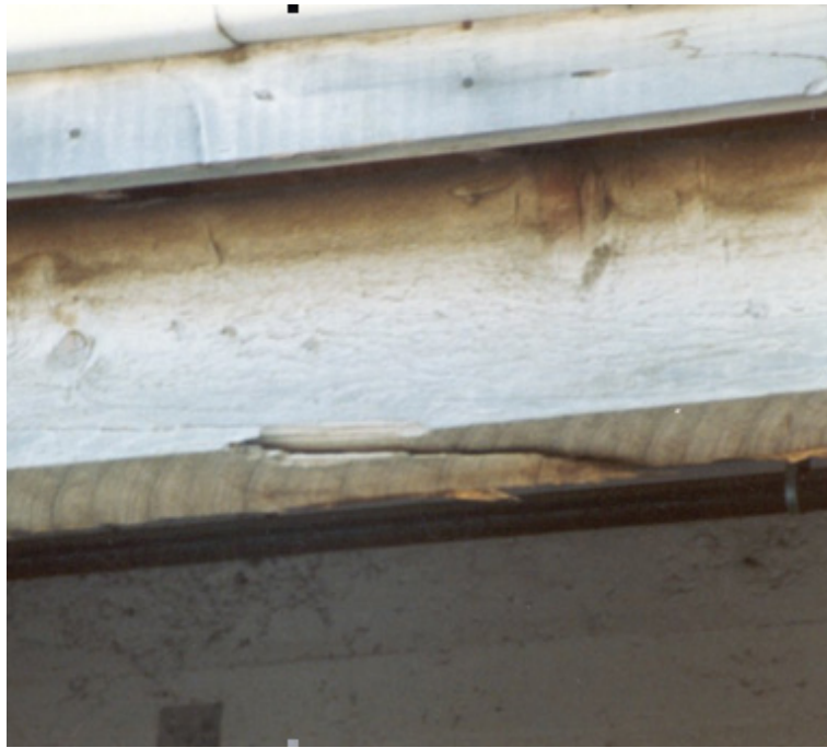
Photo 4.6-3 b) Fêlure d'une pièce
