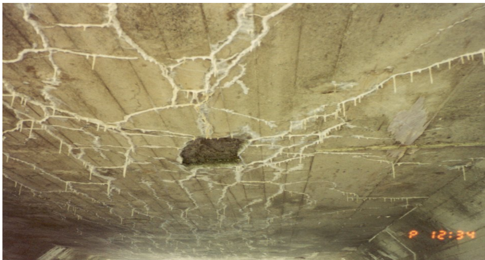
Photo 4.2-6 c) Stalactites sous une dalle
