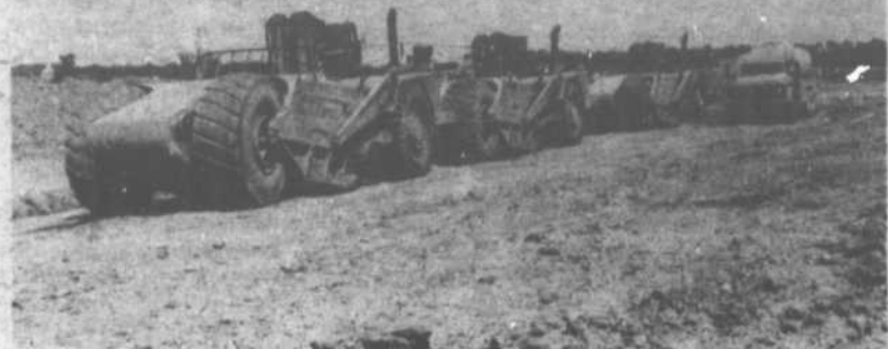
Un aperçu du matériel nécessaire à la réfection de la piste (Photo: LA REVUE)
