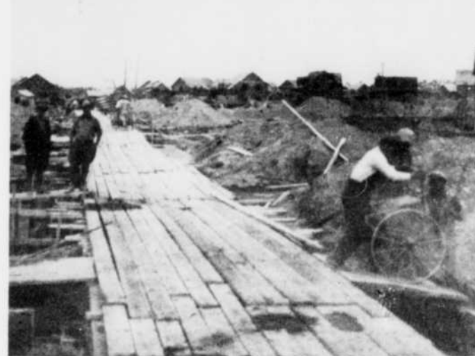
Juin 1926 - C'est à cette époque que Louis Bédard a fait ses débuts pour Alcan. Arvida était alors en pleine période de construction.
