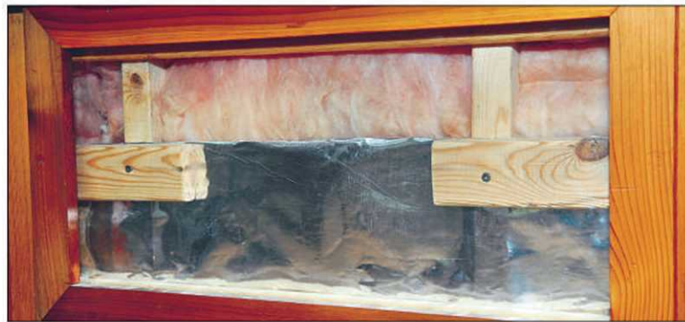
Avant de transformer une pièce en sauna, il faut poser de la laine minérale et une plaque métallique coupe-vapeur. — PHOTO LE SOLEIL, PATRICE LAROCHE
