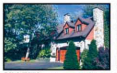
SILLERY, 2229, ONÉSIME-GAGNON , résidence de caractère, rénovée avec grand luxe, 5 cc, 2 sb, pl. bois frêne, 2 foyers et garage. 389 000$
