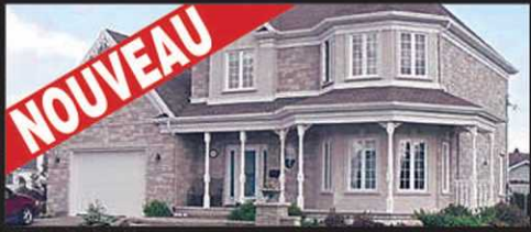
BEAUPORT, 2365, RUE VAUBERT , luxueuse et climatisée, 4 côtés pierre, 4 cc, 2 sb, 1 se, foyer, piscine creusée et garage. 440 000$
