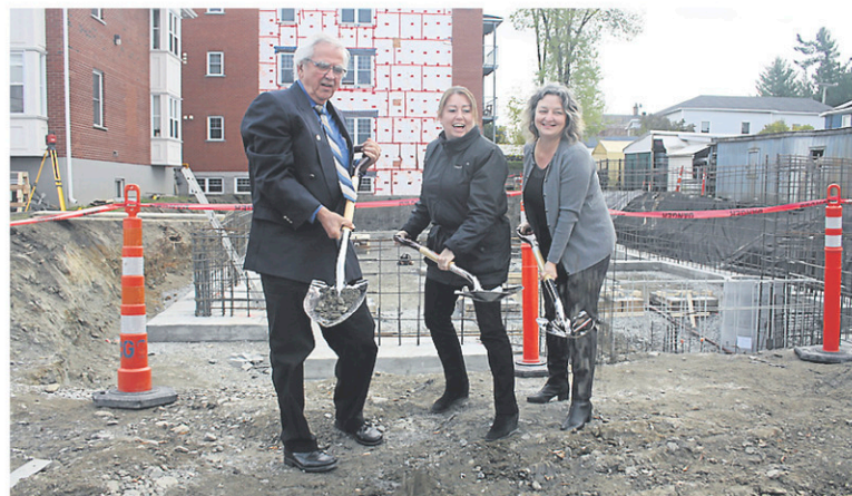
Le président de l'Accueil Notre-Dame, Maurice Rancourt, la mairesse de Magog, Vicki-May Hamm, ainsi qu'Annie Corriveau, du bureau du député Gilles Bélanger, ont procédé à la pelletée de terre officielle dans le cadre du lancement des travaux d'agrandissement de l'Accueil. — PHOTO LA TRIBUNE, JEAN-FRANÇOIS GAGNON
