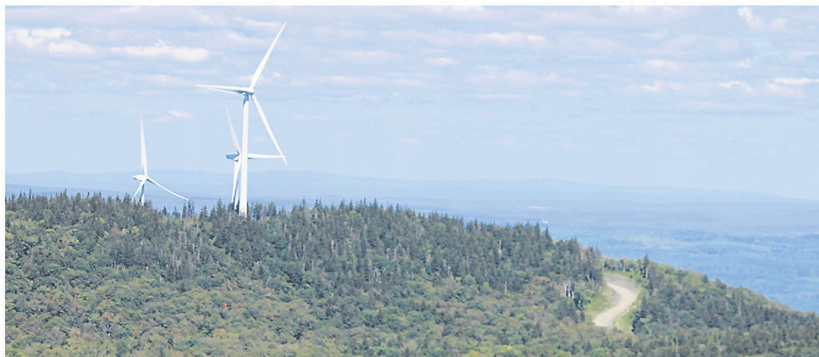
Les 12 géantes blanches du Parc éolien communautaire du Granit dominent le paysage montagneux du territoire de la municipalité de Saint-Robert-Bellarmin, à l'extrémité sud-est de la MRC du Granit. Leur rendement très performant est attribué, en partie, à la technologie utilisée, plus efficace et exigeant moins d'arrêts attribués à des bris mécaniques.
