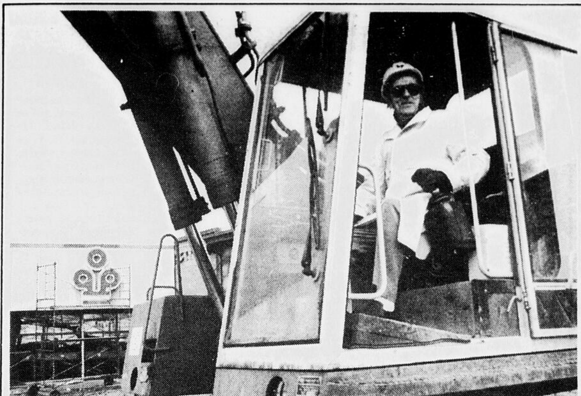
CONSTRUCTION — Le président de Place du Royaume, M. Gaston Tremblay, actionne la pelle mécanique pour la première pelletée de terre sur l'emplacement de cette importante construction.
