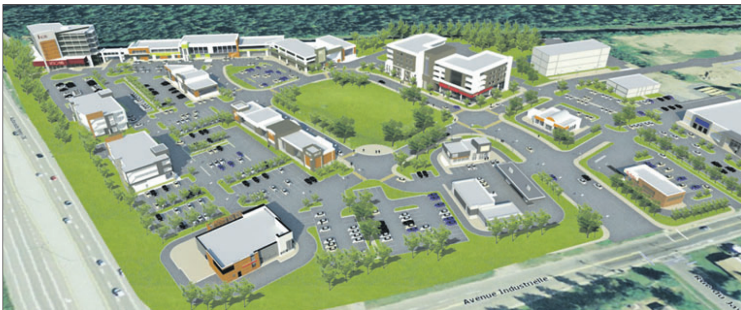
Il s'agit d'un projet d'une très grande envergure qui fera la joie des résidents de Val-Bélaïr.
