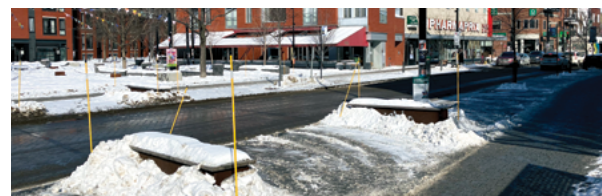
Déneigement inadéquat du mobilier de repos
