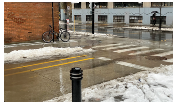
Traverses piétonnes surélevées acheminant l'eau en dehors du corridor piétonnier
