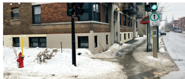
Entrées des saillies drainantes encombrées par la neige
