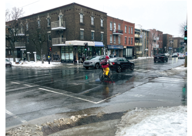
Point le plus bas de la chaussée près des bateaux pavés créant une accumulation d'eau dans le corridor piéton
