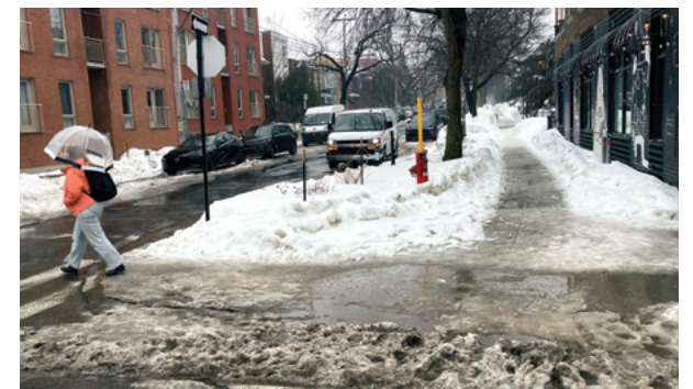
Accumulation de sloche et de glace dans les corridors piétonniers malgré les saillies drainantes
